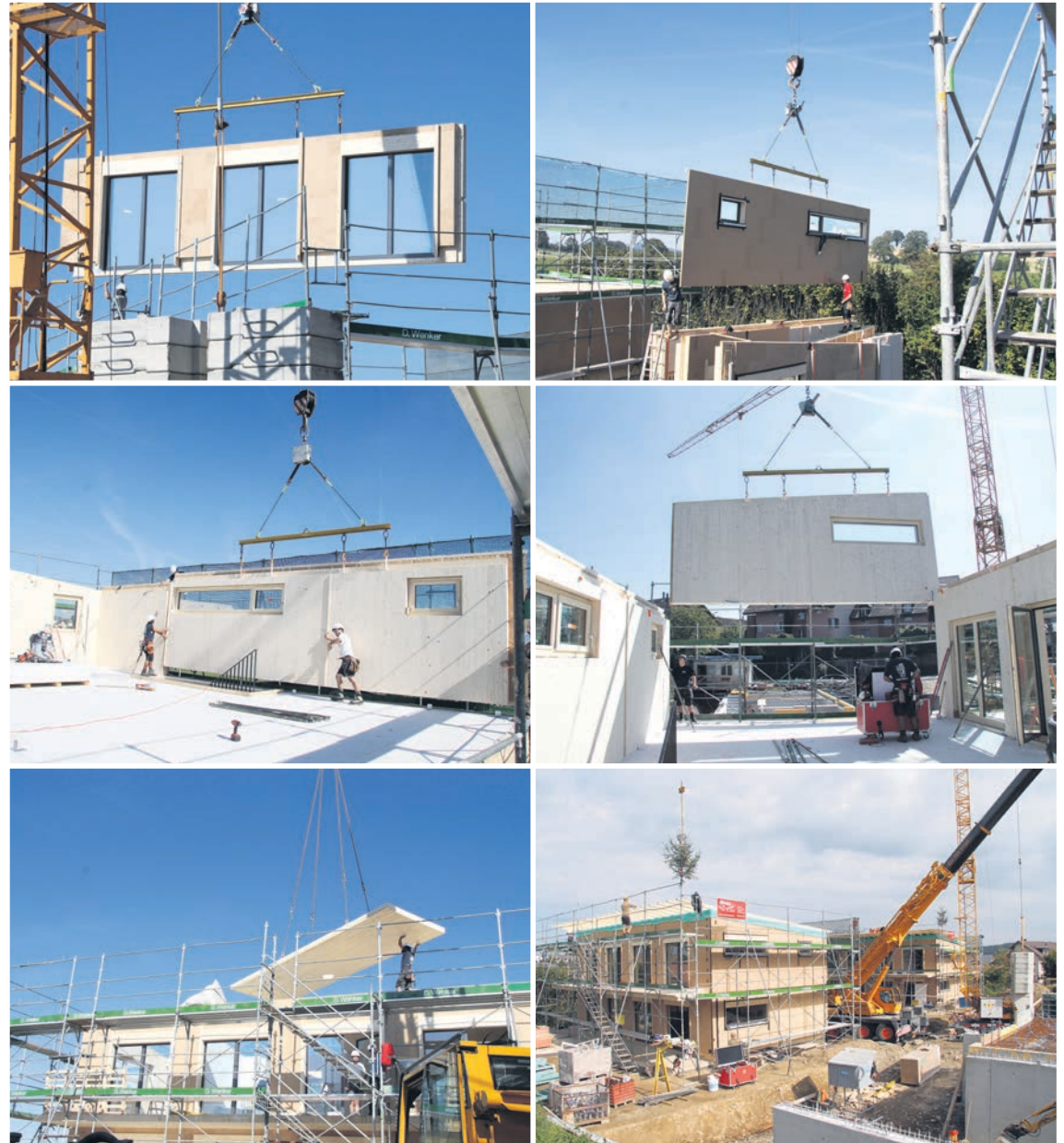
Am Langenwilweg in Schwarzenburg entstehen vier Einfamilienhäuser u.a. mit Holz aus dem Rüschegger Wald. Fotos: zvg
